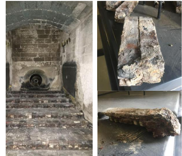
Reparierte Mauerung (links) und verschlackte Rostelemente (rechts)
